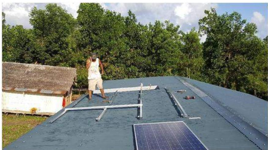
Njaka – Passage des câbles solaires de la toiture à l'armoire électrique.
