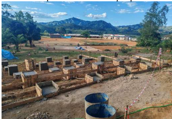
Préparation des plots qui supporteront les panneaux solaires
